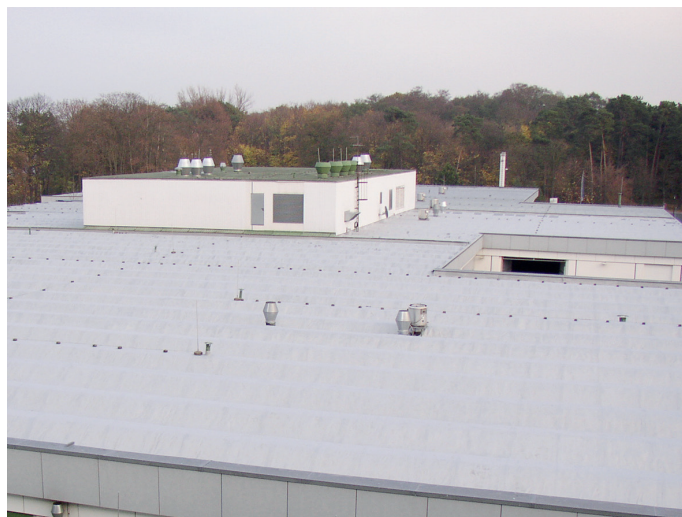
Abdichtung mit VIASAN auf einem VT-Faltendach
