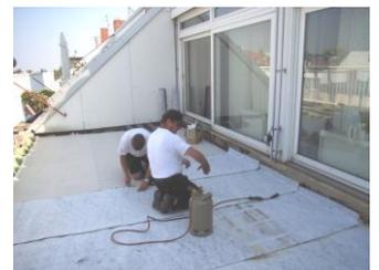
VIASAN-System auf kaschierter Zusatzdämmung aus EPS-Dämmstoff.
