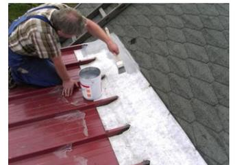
NEVOLIT-Gefällekeil mit dem VIASAN-System abgedichtet.
