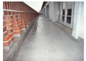
VIASAN-System auf Terrassen mit Aufdämmung aus PU-Dämmung lose verlegt + Auflast.
