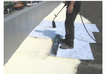
Wandanschluss mit Kehle zwischen zwei Gebäuden mit VIA-UP 3,0 ausgekleidet, Stöße mit Polyestervlies verstärkt und alles mit QuiTex DA beschichtet.
