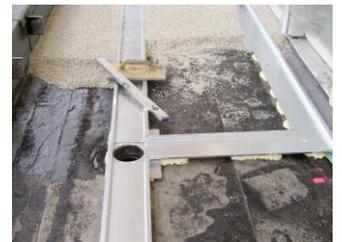
Gefälleherstellung unterhalb der zu verlegenden Dämmung
