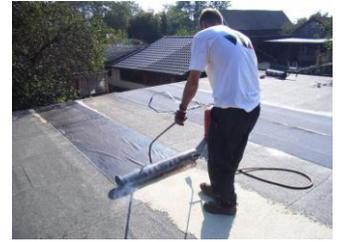
Abdichtungslage im Gieß- und Einrollverfahren verlegt.
