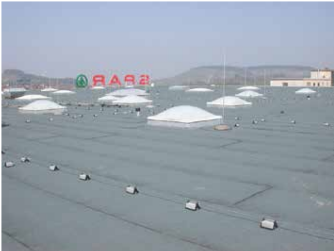
Energetische Sanierung: 1. Lage VIA-SK 2,8 2. Lage VIAPOL Schiefer
