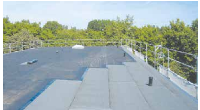
Substanzerhaltende Sanierung mit einer Lage VIAPOL
