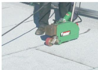
Nähte und Stöße z.B. mit Heißluft schließen
