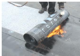
Mit Gasflamme streifenweise verschweißen.
