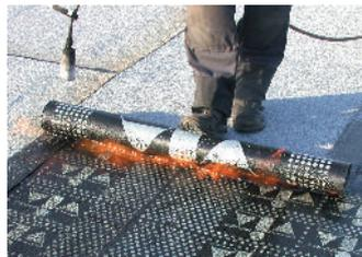
VIA-RASANT vollflächig verschweißt auf 1. Lage VIA-FKK3,0mm.
