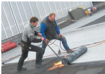
Sheddach-Sanie rung auf alter bituminöser Abdichtung
