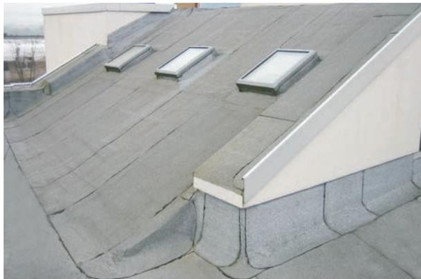
Sanierung mit einer Lage VIA-LAMBERPOL color und VIA-LAMBERTEX color als Anschlussbahn
