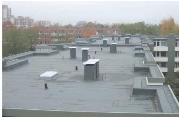
Energetische Flachdachsanie rung, Oberlage VIA-LAMBERPOL schiefer
