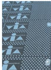
1. Lage VIA-FKK mit Zusatzdämmung auf alter Folienabdichtung
