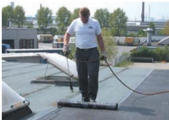
Instandsetzung alter Elastomer-Abdichtung mit VIA-LAMBERPOL
