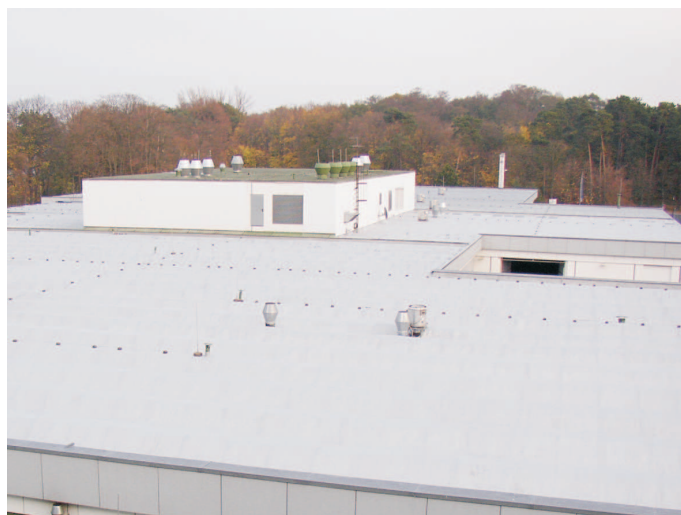
Abdichtung mit VIASAN auf einem VT-Faltendach
