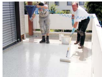
Gleichmäßige Chipseinbringung mit Trichterpistole
