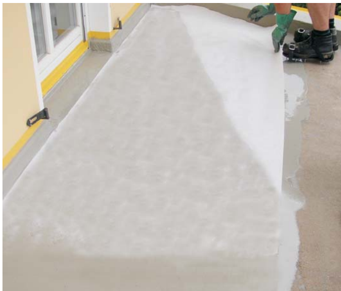
Polyestervlies als Armierung für das Abdichtungssystem
