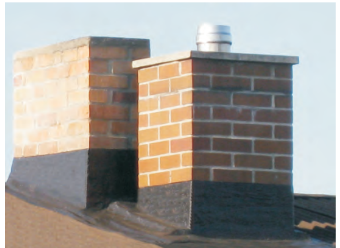
Eindichtung eines Schornsteins mit QuiTex DA
