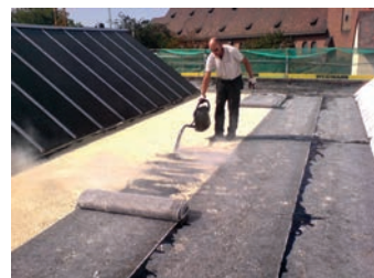
1. Lage VIA-UP 2,2 im Gieß- und Einrollverfahren, 2. Lage aus z.B. VIA-LAMBERPOL
