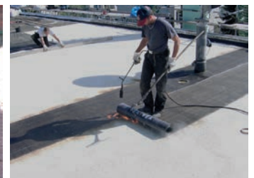
Oder: 1. Lage VIA-RUN P4 vollflächig aufgeflämmt, 2. Lage aus z.B. VIA-LAMBERPOL
