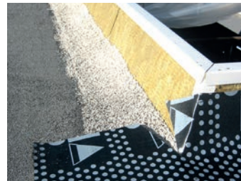
Verfüllen von Montageöffnungen bei nachträglichen Einbauten
