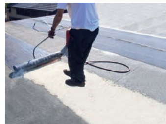
Verfüllen von Vertiefungen/Lunken
