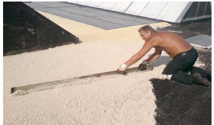
Gefälleschüttung auf gesamter Dachfläche (s. Verlegeanleitung)
